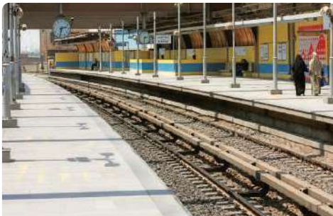
محطة مترو في القاهرة
